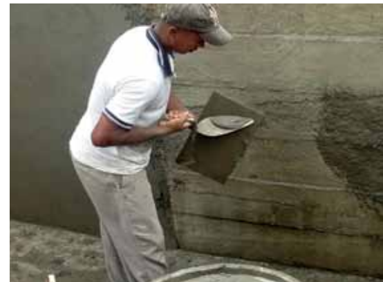
Anschließend wurden die Gräben für die Wasserleitungen gegraben.
