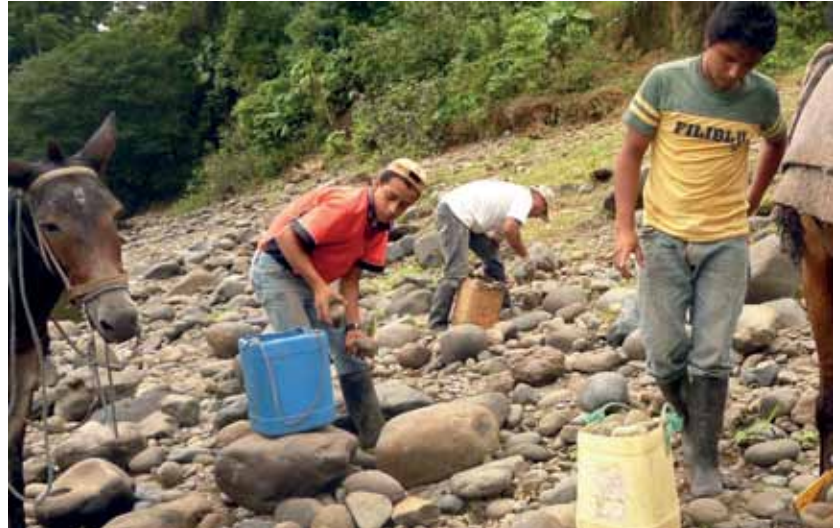
Zuerst mussten die Steine für das Fundament geholt werden, dann begann der Bau der Zisternen.
